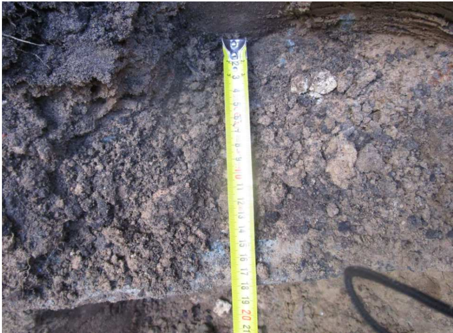
Fot.2 Odkrywka odsadzki fundamentów
